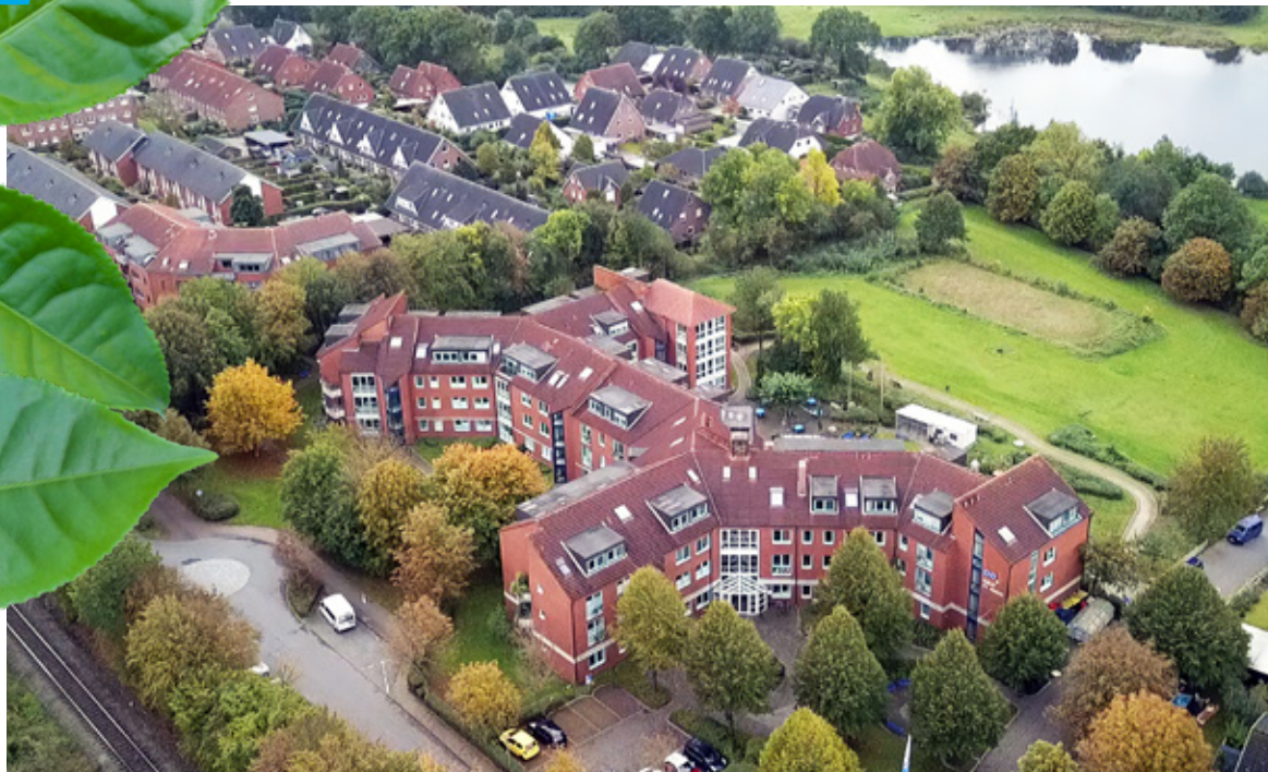
Haus St. Anna: Das Alten- und Pflegeheim in Schwentimental spart durch ihre neue Heizungsanlage 200.000 kWh pro Jahr ein.
